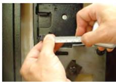
1. Medir a espessura da porta do cofre (distância da superfície de montagem da fechadura até a superfície de montagem do teclado). Somar ¼" (19 mm), e cortar o fuso de alumínio neste comprimento.
