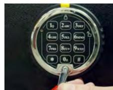
12. Instalar e apertar os parafusos que seguram o teclado, conforme ilustração. Usar a chave de fenda de segurança unidirecional para as aplicações EN1300. A chave Phillips é aceitável para todas as outras aplicações. Assim que o parafuso estiver no lugar cubra-o com o adesivo da logomarca da S&G logo após retirar a película protetora da logomarca.
